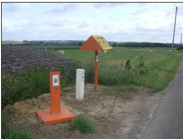
Figure 514 : Photographie des marques du passage de la conduite de gaz entre Oret et Mettet
