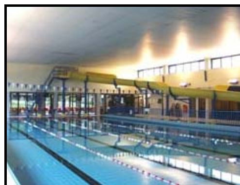
Figure 488 : Photographie de la piscine de Biesme (Source : site internet de la commune)
