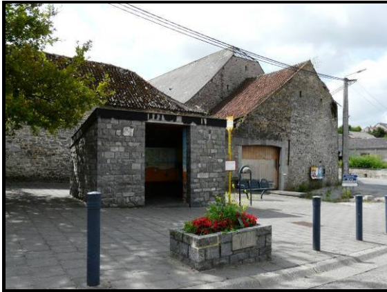
Figure 451 : Photographie de l'abri bus à Biesmerée
