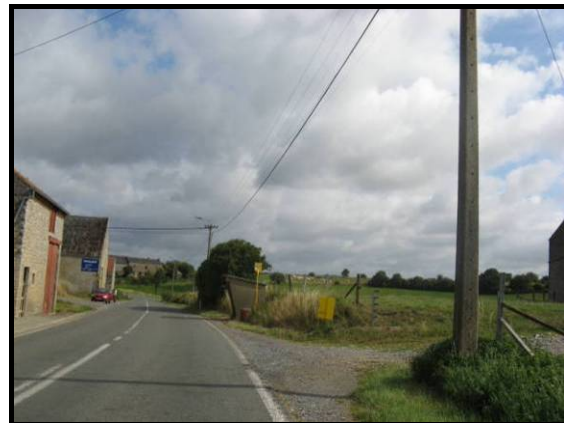
Figure 450 : Photographie de l'abri bus sur la N977 entre Biesme et Oret
