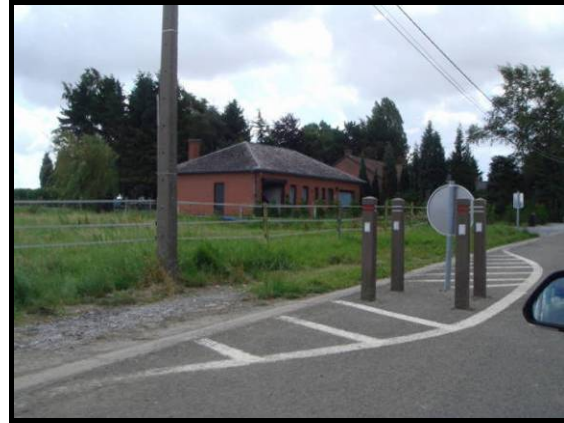
Figure 456 : Photographie de la chicane dans la rue Bois du Prince à Mettet
