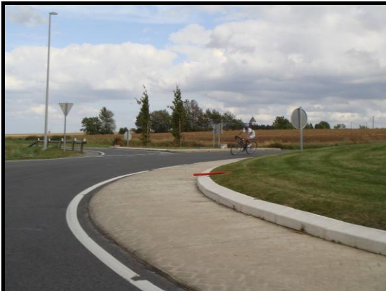
Figure 411 : Photographie du rond-point au croisement entre la N951 et la N932
