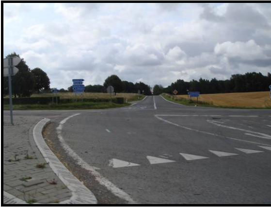
Figure 403 : Photographie du carrefour entre la 977 et la N932
