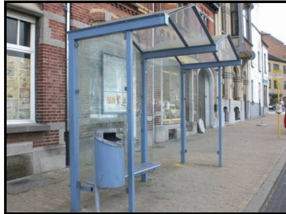
Figure 448 : Photographie de l'abri bus situé rue Albert 1 er à Mettet
