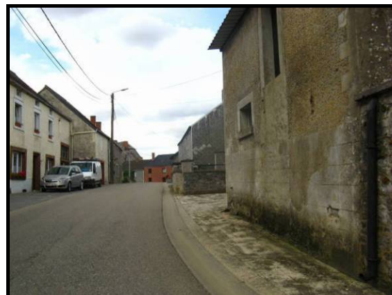
Figure 430 : Photographie du trottoir étroit dans la rue des Blés à Graux
