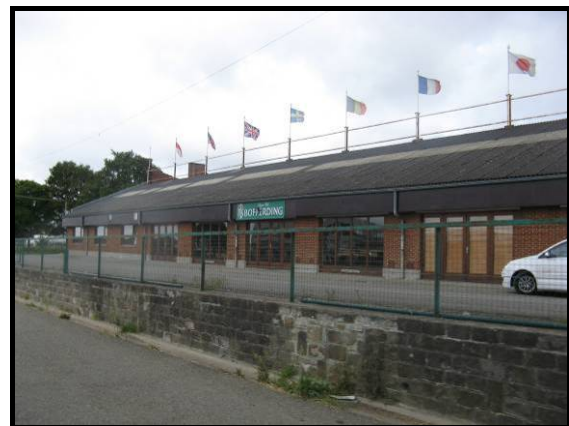
Figure 406 : Photographie du bâtiment adjacent au circuit
