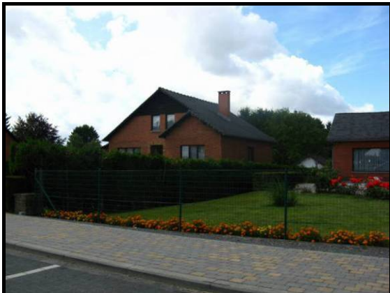
Figure 433 : Photographie du trottoir de la rue Albert 1 er à Mettet
