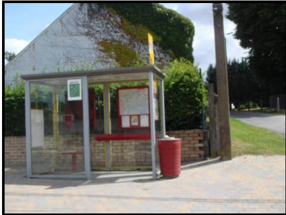
Figure 447 : Photographie de l'abri bus situé rue Albert 1 er à Mettet
