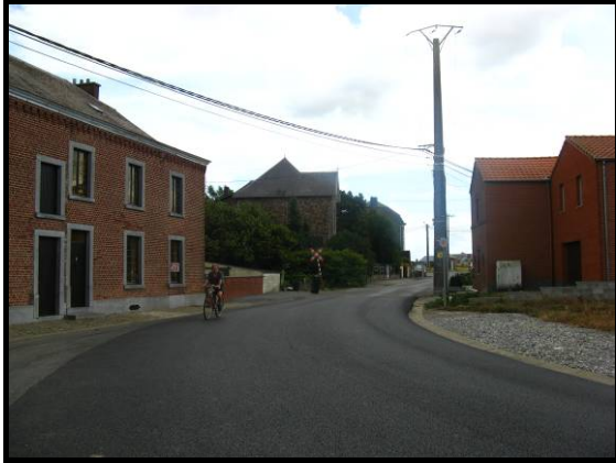
Figure 409 : Photographie du nouveau revêtement de la N933 dans Brossière
