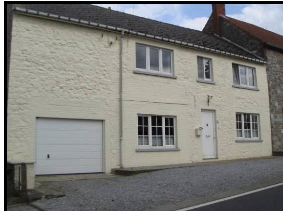
Figure 412 : Photographie d'une habitation en bordure de la N951 dans Saint-Gérard
