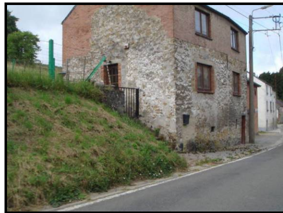
Figure 428 : Photographie d'absence de trottoir dans la rue de Biesme (N977) à Oret
