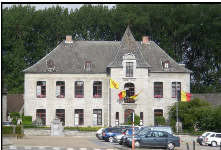
Figure 35 : Photographie de la maison communale de Mettet
