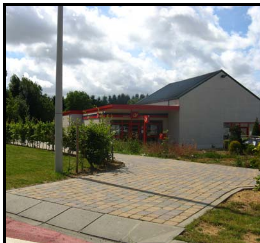
Figure 36 : Photographie d'un bureau de poste à Mettet
