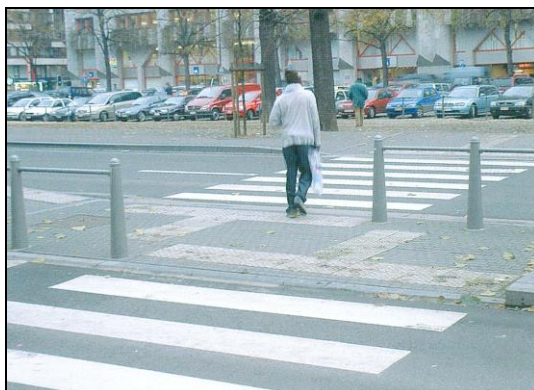
Figure 42 : Photographie, traversée en baïonnette
